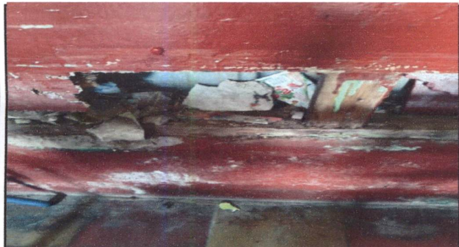
Foto 3: Desmantelar aula de madera y metal, levantamiento y sustitución de aulas de block
