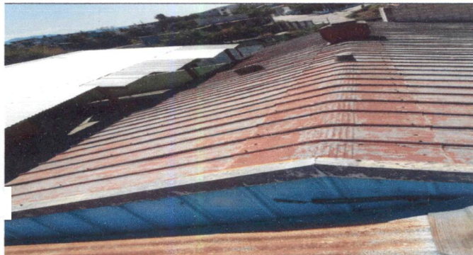
Foto 1: Sustitución de lámina, por lamina troquelada aluzinc calibre 26 (3 salones), desmontaje de lámina antigua e instalación de lámina nueva.
