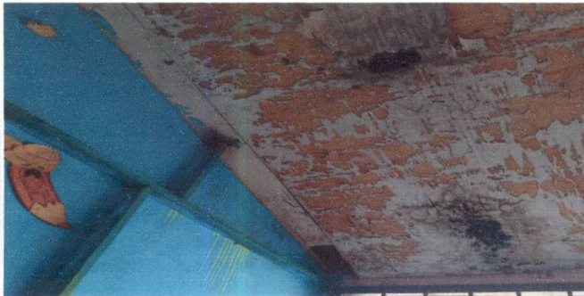
Foto 7: Sustitución de estructura de soporte de madera por metal, desmontaje de madera por metal e instalación de costaneras.
