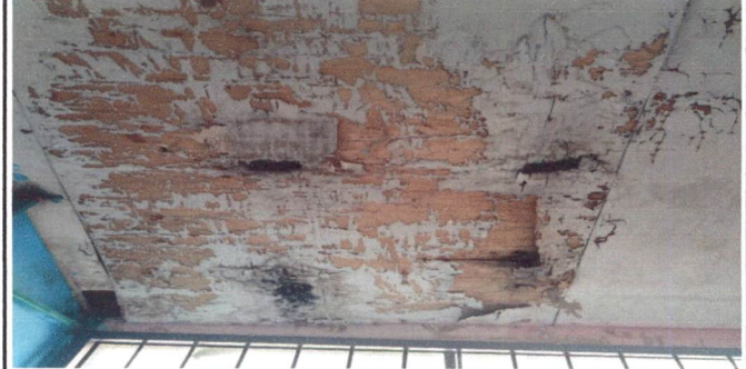
Foto 8: Sustitución de estructura de soporte de madera por metal, desmontaje de madera por metal e instalación de costaneras.
