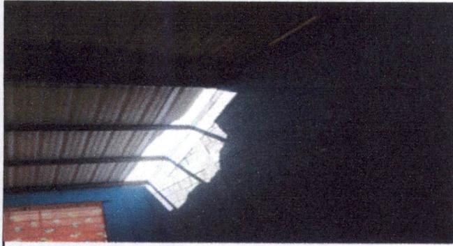
**CUBIERTA DE LAMINA:** Sustitución de lámina plastica por lamina troquelada aluzinc calibre 26, en salones de segundo grado, ubicados en el segundo nivel.
