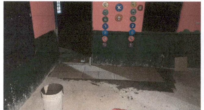
Foto 4: SE EMPIEZA A COLOCAR EL NUEVO PISO
