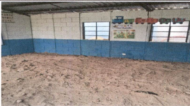
Foto 3: MEZCLA DE CEMENTO CAL Y SELECTO
