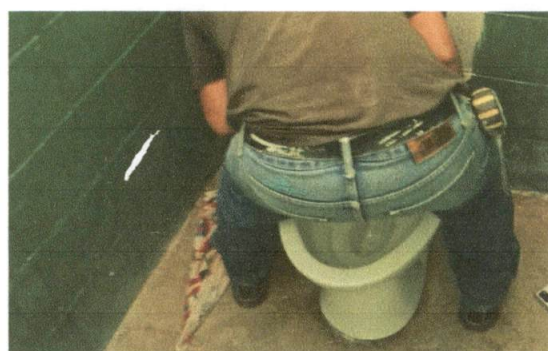
Foto 2: SUSTITUCIÓN DE BAÑOS
