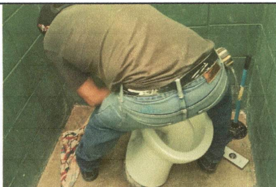
Foto 3: SUSTITUCIÓN DE BAÑOS
