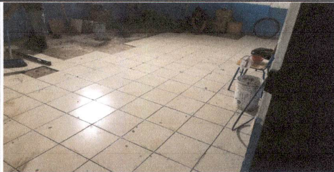
Foto 5: SEGUIMIENTO DEL PISO EN LAS AULAS
