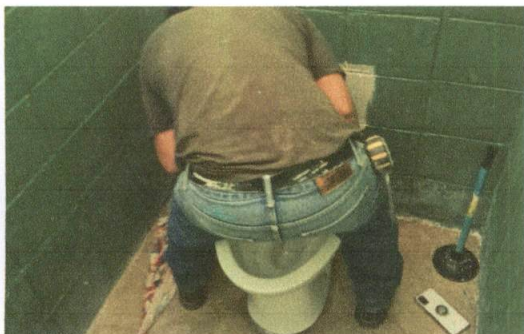
Foto1: SUSTITUCIÓN DE BAÑOS
