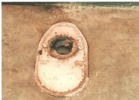
Foto 5: SUSTITUCIÓN DE BAÑOS
