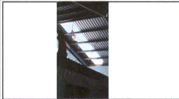
Foto1: Sustrucción de lamina, por lamina troquelada aluzinc calibre 26
