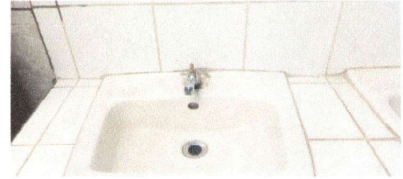
Foto 2: Sustitucion de accesorios e inodoros y lavamanos.
