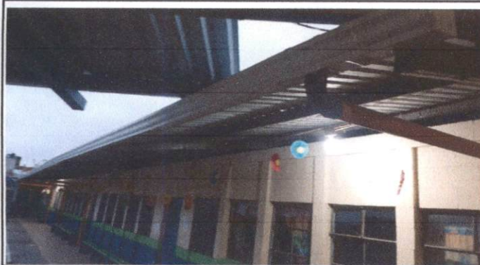
FOTO 3: SUSTITUCION DE CANAL DE METAL POR CANAL DE PVC
