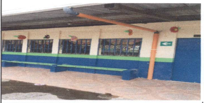
FOTO 4: REPARACION DE BAJADA DE AGUA PLUVIAL, TUBO PVC 3"
