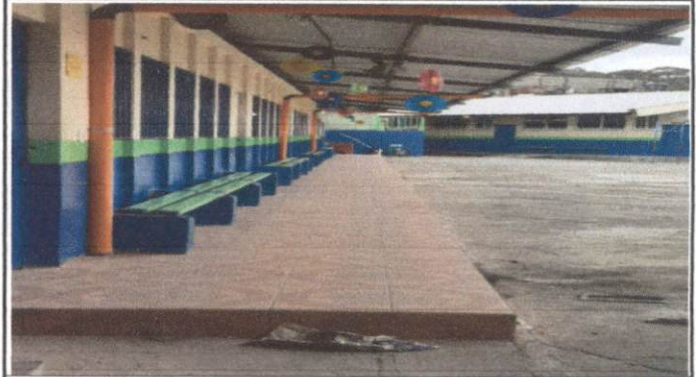
FOTO 2: SUSTITUCION DE PISO DE TORTA DE CONCRETO POR PISO CERAMICO DE PATIO
