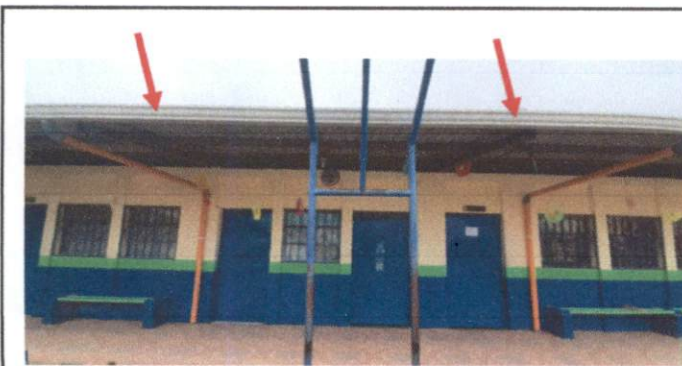
FOTO 5: SUSTITUCION DE SOPORTE O PESCANTE DE METAL PARA CANAL GAZA 4", PLANA DE 1" x 1/4", DE 0.35 mm ANCHO
