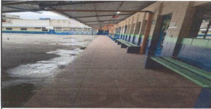
FOTO 1: REPARACION DE PISO DE TORTA DE CONCRETO POR PISO CERAMICO
