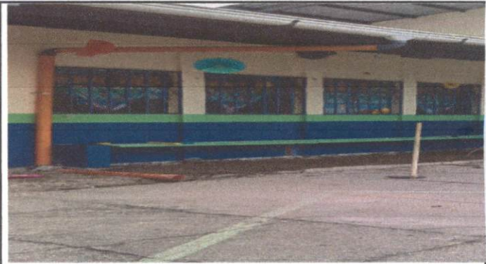
FOTO 4: REPARACION DE BAJADA DE AGUA PLUVIAL, TUBO PVC 3"
