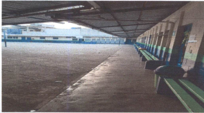
FOTO 1: REPARACION DE PISO DE TORTA DE CONCRETO POR PISO CERAMICO
