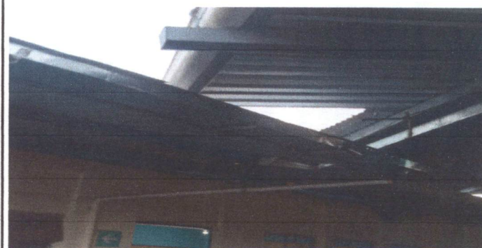
FOTO 4: REPARACION DE BAJADA DE AGUA PLUVIAL, TUBO PVC 3"
