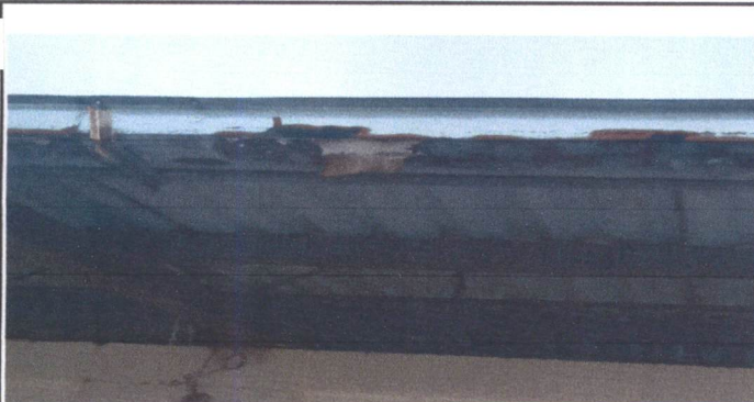
FOTO 5: SUSTITUCION DE SOPORTE O PESCANTE DE METAL PARA CANAL GAZA 4", PLANA DE 1" x 1/4", DE 0.35 mm ANCHO
