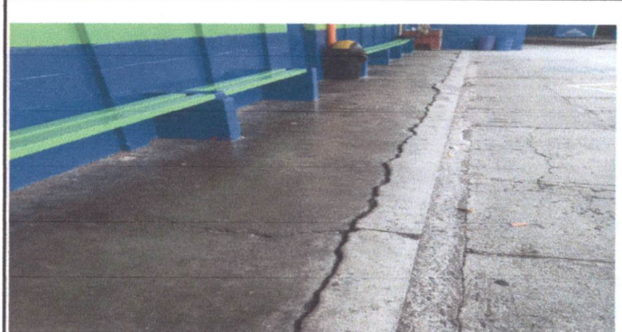
FOTO 2: SUSTITUCION DE PISO DE TORTA DE CONCRETO POR PISO CERAMICO DE PATIO
