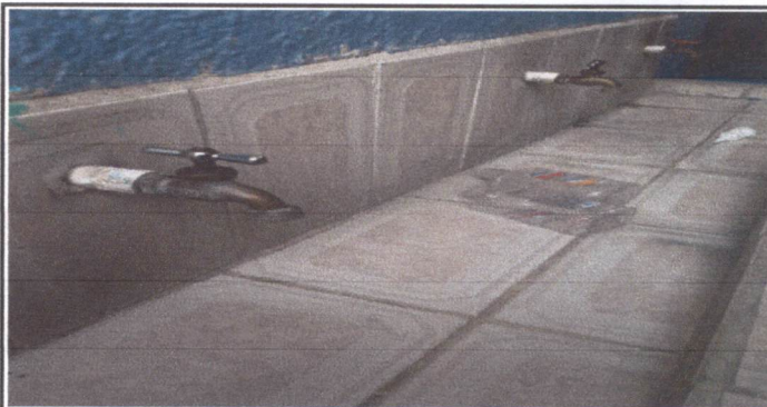
FOTO 6: SUSTITUCION DE LLAVE DE CHORRO
