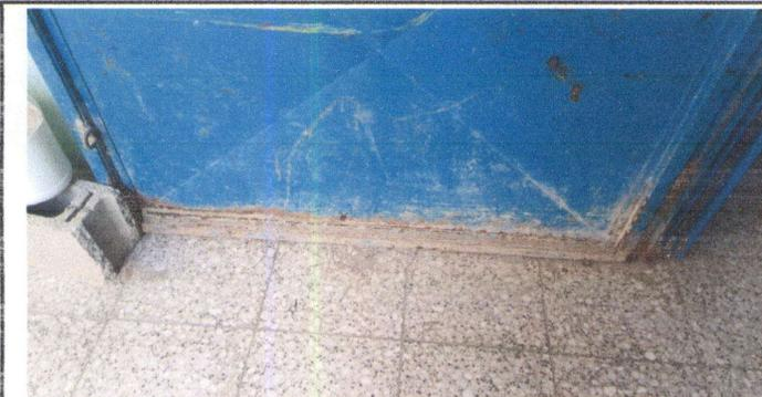
Foto 3: cambio de lamina y tubo de puertas
