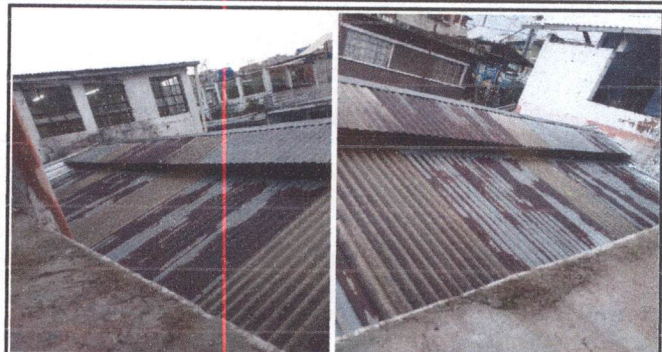
Foto 2: TECHO DE PATIO: Desmontaje y enlaminado a dos aguas con claraboya central, en patio del primer nivel.
