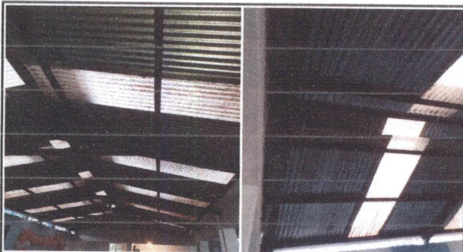
Foto 3: TECHO DE PATIO: Mantenimiento preventivo de estructura metálica (tijeras y costaneras) de techo en patio del primer nivel lijado, cepillado, aplicación de fondo zincromato y pintura anticorrosiva.
