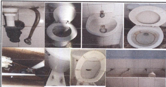
Foto 5: SERVICIOS SANITARIOS: Cambio total de inodoros en baños, cambio total de lavamanos y cambio de chorros en lavamanos de baños.
