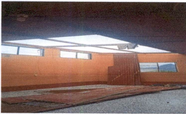
FOTO 1: Sustrucción de lámina por lámina troquelada ALUZINC
