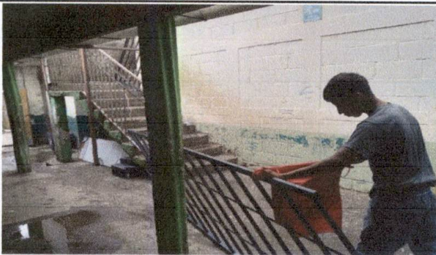
FOTO 3: Sustrucción de barandas
