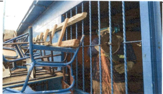
FOTO 4: Fabricación de 6 ventana de hierro con vidrio .
