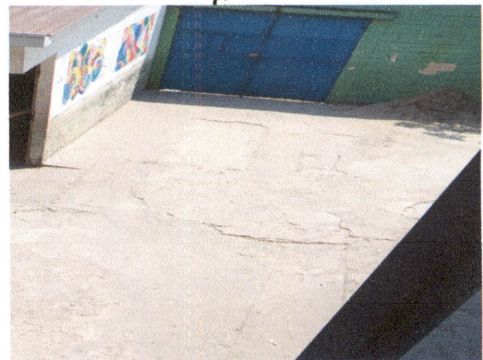
Sustitución de piso tipo torta en entrada principal
