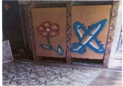
Sustitución de puertas de metal en servicio sanitario
