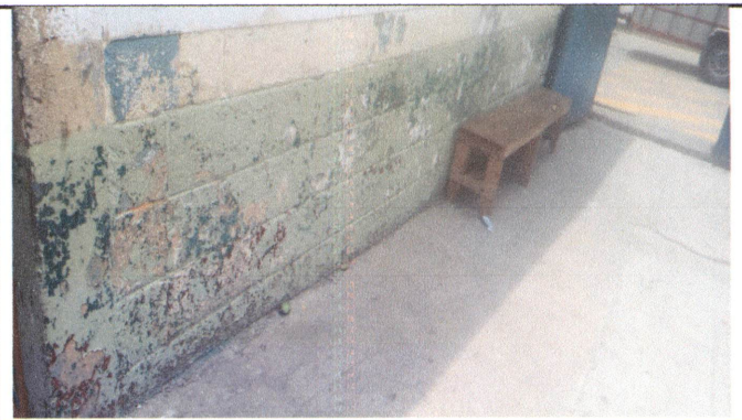
pintura en muros interiores y exteriores
