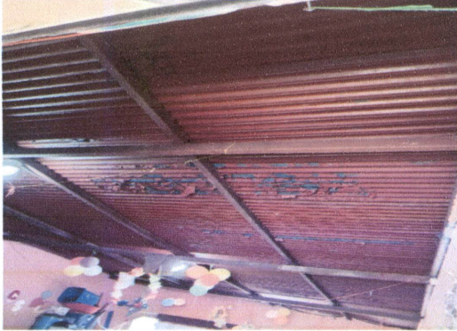
Sustitución de lámina por lámina troquelada aluzinc calibre 26 , en aula de 4to. Grado.
