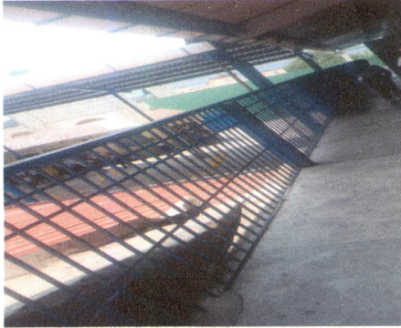
Mantenimiento a baranda de metal del segundo nivel
