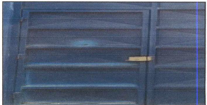
Foto 4: Sustitución de chapa Yale a porton principal.
