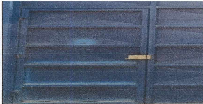
Foto 4: Sustitución de chapa Yale a porton principal.
