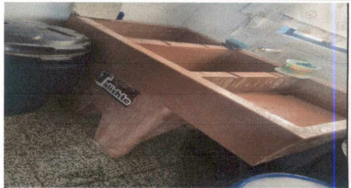
Foto 4: Sustitucion de pila plastica de 2 lavaderos por pila de concreto azulejeada.
