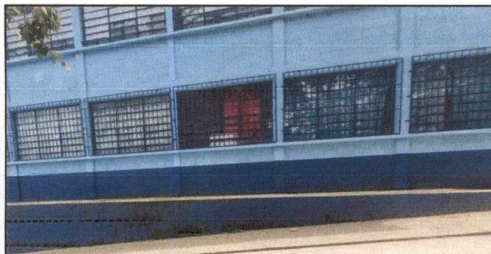
Foto 6 :Aplicación de pintura de aceite en muros Exteriores.
