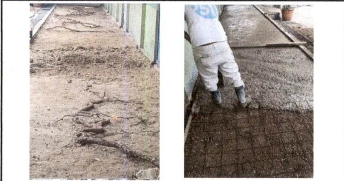
Foto 4-5: Instalación de torta de concreto de pasillo 71m2
