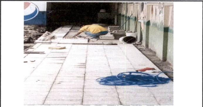
Foto 6: Instalación piso de granito 71m2
