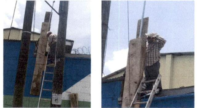
Foto 12-13: Instalación de una acometida eléctrica
