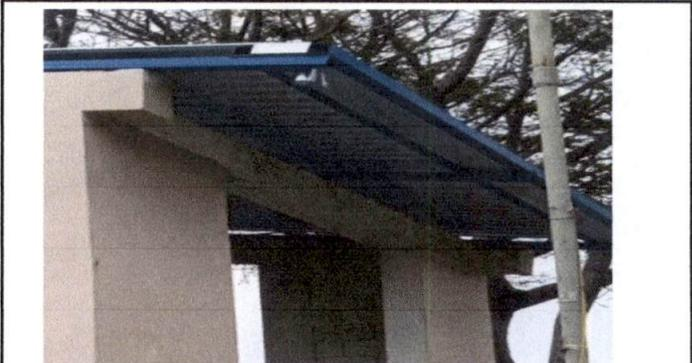
Foto 3: Instalación de lámina troquelada de aluzinc calibre 26, 38m2
