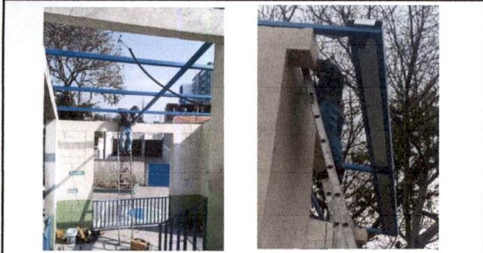
Foto 1-2: Instalación de lámina troquelada de aluzinc calibre 26, 38 m2
