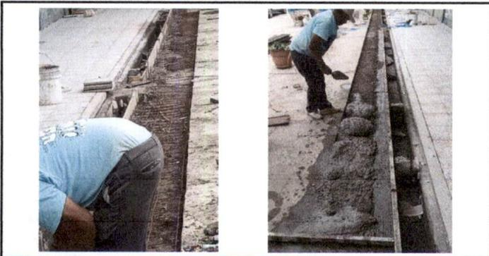
Foto 7-8: Reparación cuneta de concreto 40m2
