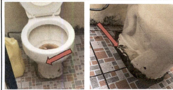
Foto 13 y 14: 14. REPARACIÓN DE RED DE DRENAJE 14.2 Sustitución de tubería PVC línea principal de aguas negras de 2 inodoros de varones
