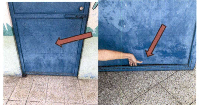
Foto 3 y 4: 4. PUERTAS DE METAL 4.1 Mantenimiento a estructura de 8 puertas de aulas ( lijado, sujeciones, aplicación de pintura )
