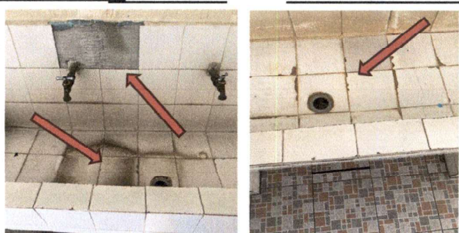
Foto 11 y 12: 13. REPARACIÓN O SUSTITUCIÓN DE AZULEJO 13.1 Sustitución de azulejo de 1 lavamanos de baños de niños y 1 lavamanos de baños niñas
