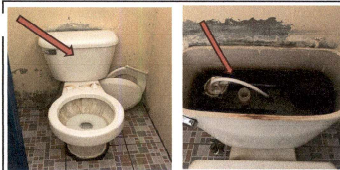
Foto 9 y 10: 10. SERVICIOS SANITARIOS Y SUS ACCESORIOS 10.2 Sustitución de accesorios de los depositos 4 sanitarios de niñas y 2 sanitarios de niños
