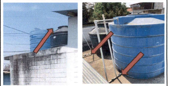
Foto 15 y 16: 18. REPARACIÓN Y MANTENIMIENTO DE DEPOSITOS DE AGUA 18.5 Sustitución de accesorios de 2 depositos de agua
