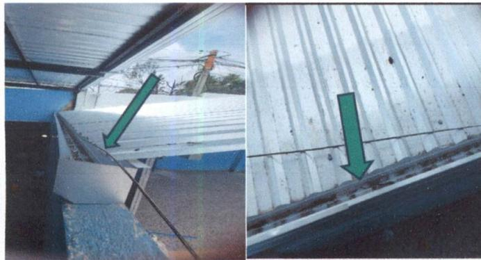
Foto 11: Sustitución de canal PVC por canal aluzinc calibre 26 en el escenario
