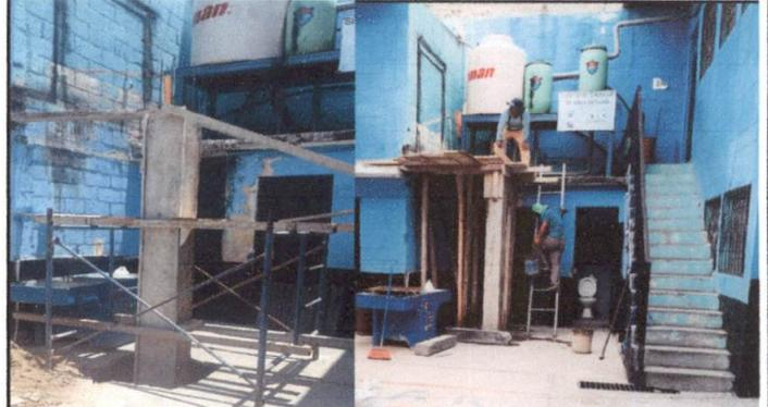
Foto 26: Fundición de losa para instalación de tinaco para agua.
