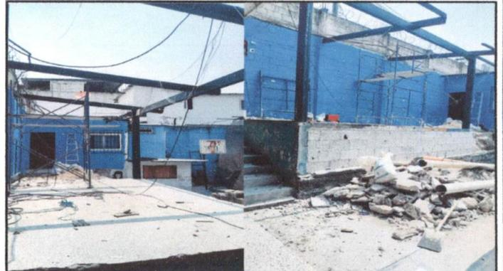
Foto 2: Sustitución de lámina del escenario por lámina troquelada de aluzinc calibre 26 anclada con tornillo punta de broca sellada con sicaflex
