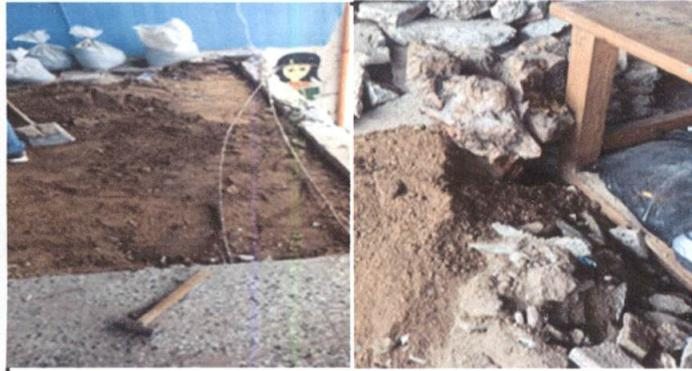
Foto 7: Sustitución de piso de granito en el escenario
