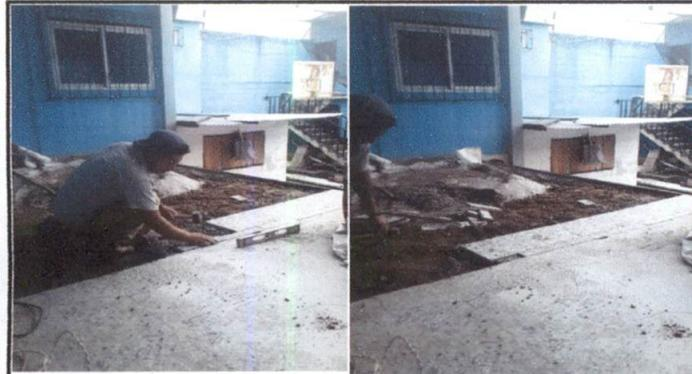
Foto 9: Sustitución de piso de granito en el escenario
