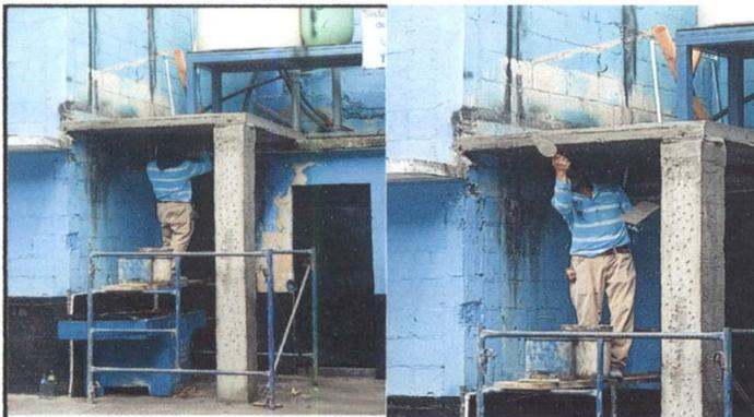
Foto 27: Fundición de losa para instalación de tinaco para agua.
