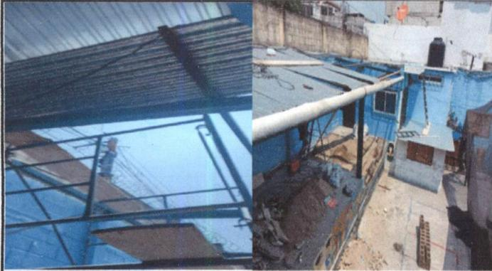
Foto1: Sustitución de lámina del escenario por lámina troquelada de aluzinc calibre 26 anclada con tornillo punta de broca sellada con sicaflex
