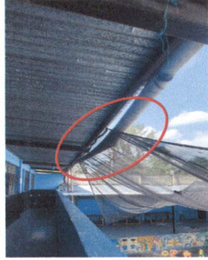
Foto 02: Sustitución de canal PVC por aluzinc calibre 26. Dicho canal tendrá una carrera a todo lo largo del techo superior lo cual irá sostenida por una armadura de costanera de 3" X 2"
