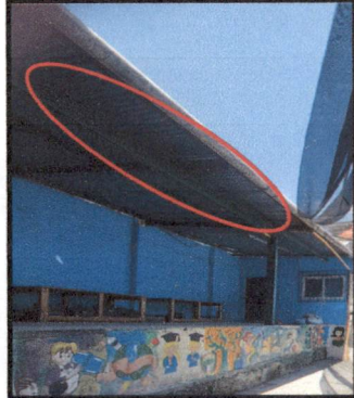
Foto 01: Sustitución de lámina del escenario por lámina troquelada de Aluzinc calibre 26 con instalación y materiales incluidos.
