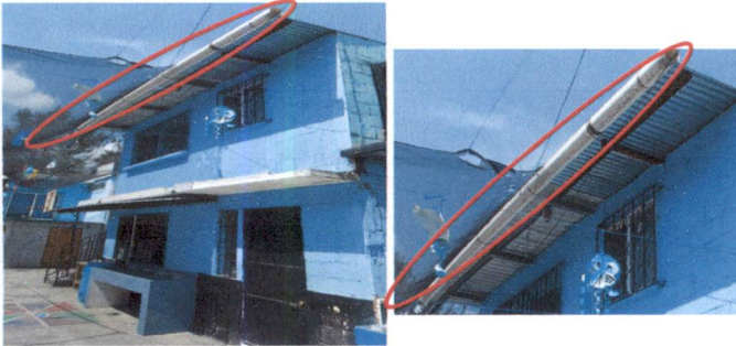
Foto 07: Instalación de canal aluzinc en aula superior, se instalará una estructura metálica para soportar un canal cuadrado tipo aluzinc calibre 26 con tope y una bajada de 3"
