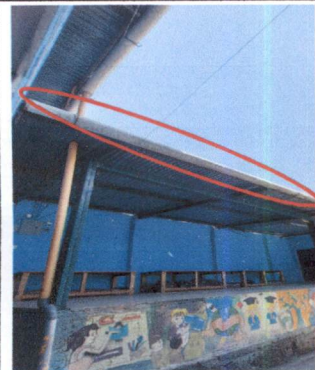
Foto 03: Sustitución de canal de PVC en el escenario en su totalidad y cambio de forma a dos aguas se colocarán canales cuadrados de aluzinc calibre 26 con tope con su respectiva bajada
