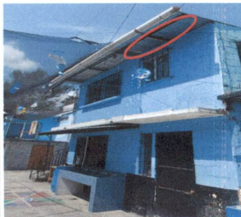
Foto 04: Sustitución de lámina de aula 2do nivel por lámina troquelada de aluzinc calibre 26 con instalación incluida
