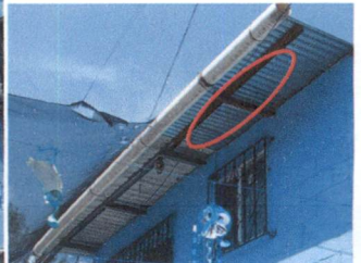
Foto 04: Sustitución de lámina de aula 2do nivel por lámina troquelada de aluzinc calibre 26 con instalación incluida
