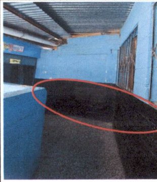
Foto 06: Pintura de aceite anticorrosiva, pintura de aceite, thinner laca en zócalos exteriores en aulas color negro, puertas por dentro y por fuera
