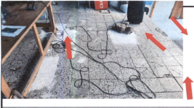
Foto 09 Sustitución de piso de granito del escenario del establecimiento por piso de granito
