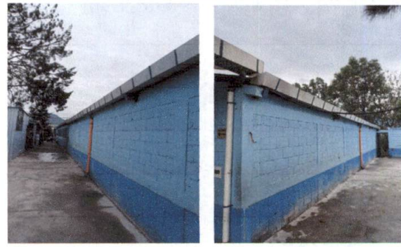
Foto 6: Reparación de canales y caídas de agua en area trasera de 24 ML
