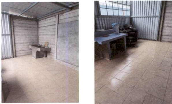
Foto 3: Sustitución de pisos.
