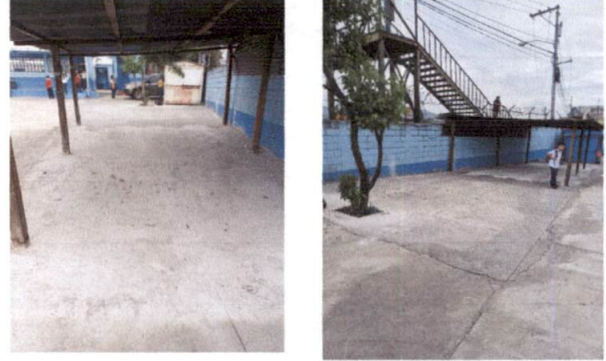
Foto 2: Reparación de piso de concreto.
