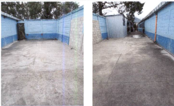
Foto 5: Reparación de piso de torta de concreto en área de patio trasero 50 M2
