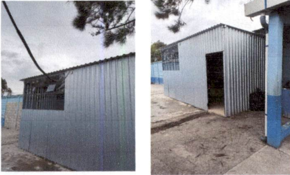
Foto 1: Suministro e instalación 66 M2 de lámina troquelada, aluzinc calibre 26 con tubo galvanizado de 2x3 chapa 16 color natural en cocina
