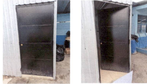
Foto 2: Sustitución de puerta en cocina
