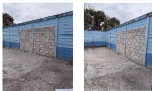
Foto 4: Reparación muro perimetral aledaño a barranco de 12 M2
