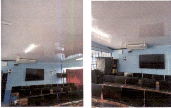
Foto1: Instalación cielo falso, laboratorio de computación.
