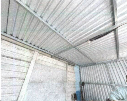
Foto1: Sustitución de lámina en el área de cocina.
