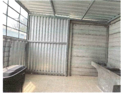
Foto 2: Sustitución de lámina en el área de cocina.
