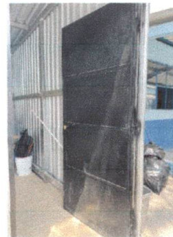
Foto 6: Sustitución de puerta en cocina.
