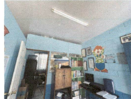
Foto 4: Mejoramiento de estructura de techo en laboratorio y área de dirección con cielo falso.
