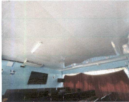
Foto 3: Mejoramiento de estructura de techo en laboratorio y área de dirección con cielo falso.
