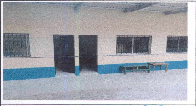
Foto 5: Pintura en muros exteriores e interiores de las aulas de párvulos, primero B y exterior de baños.
