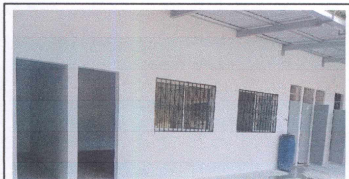
Foto 11: REPARACIÓN DE REPELLO Y CERNIDO DE PARDES: Repello y alisado del area paredes exteriores, parvulos, primero B y paredes exteriores de baños. Incluye mantenimiento de paredes por mal estado,
