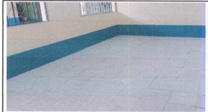
Foto 4: Sustitución de piso de torta de concreto por piso granito. Incluye levantado de torta de cemento existente, aplicación de mezción y nivelación de suelo. En aulas de párvulos, primero B y 5to.
