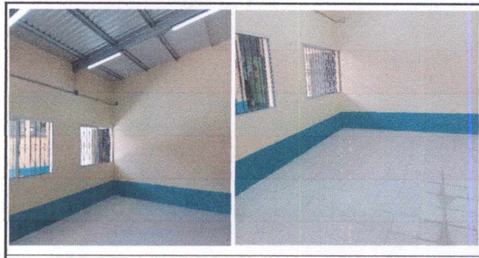
Foto 6: PINTURA: Pintura en muros exteriores e interiores de las aulas de párvulos, primero B y exterior de baños.
