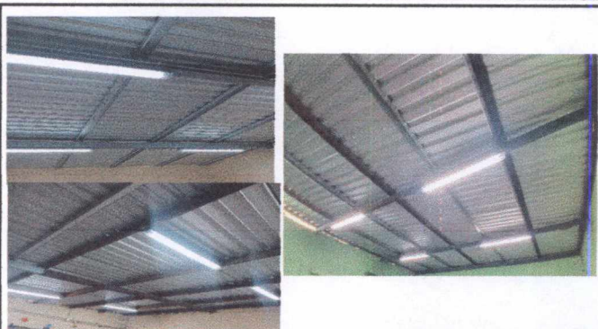
Foto 8: MANO DE OBRA ESPECIALIZADA (ELECTRICIDAD) : Instalación de unidades de iluminación con lámparas a prueba de polvo y humedad, con 2 tubos led de 18 watts (incluye interruptor, ducto y cable eléctrico)
