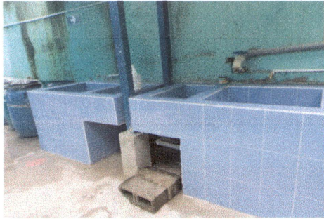
FOTO 7: INSTALACIÓN DE PILAS DE CONCRETO
