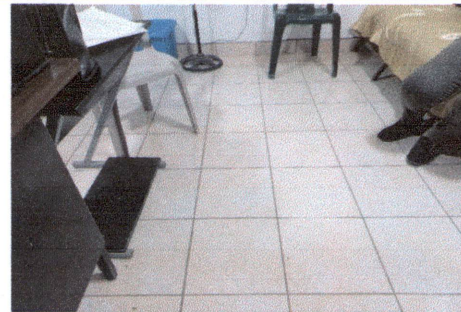
FOTO 10: INSTALACIÓN DE PISO CERÁMICO EN DIRECCIÓN
