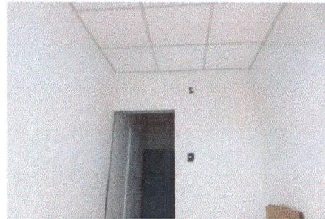
FOTO 4: INSTALACIÓN DE CIELO FALSO Y APLICACIÓN DE REPELLO Y CERNIDO
