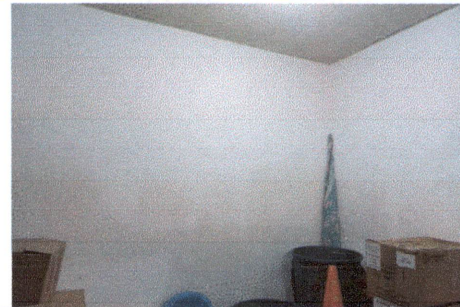
FOTO 6: APLICACIÓN DE REPELLO Y CERNIDO EN ÁREA DE PUNTO DE APOYO
