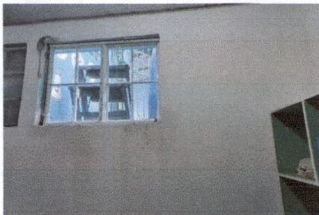
FOTO 11: APLICACIÓN DE REPELLO Y CERNIDO EN PUNTO DE APOYO INTEGRAL
