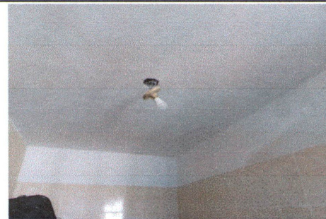
FOTO 12: APLICACIÓN DE REPELLO Y CERNIDO EN MURO Y CIELO DE COCINA
