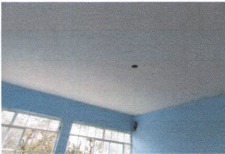
FOTO 9: APLICACIÓN DE REPELLO Y CERNIDO EN CIELO EN AULA DE 3RO.
