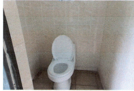
FOTO 2: SUSTITUCIÓN DE INODOROS EN SERVICIOS SANITARIOS
