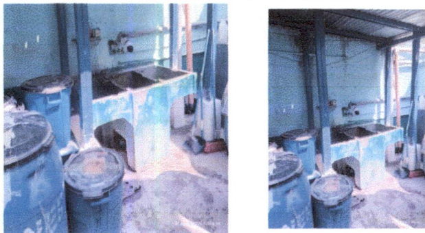
Foto 5: sustitución de pila
