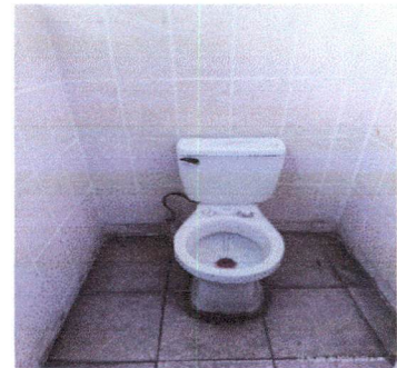
Foto 6: Sustitución de inodoros con sus accesorios en servicios sanitarios de niños y niñas.
