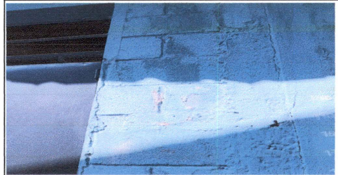
Foto 4: sellado de grietas y fisuras en muros, aplicación se cernido
