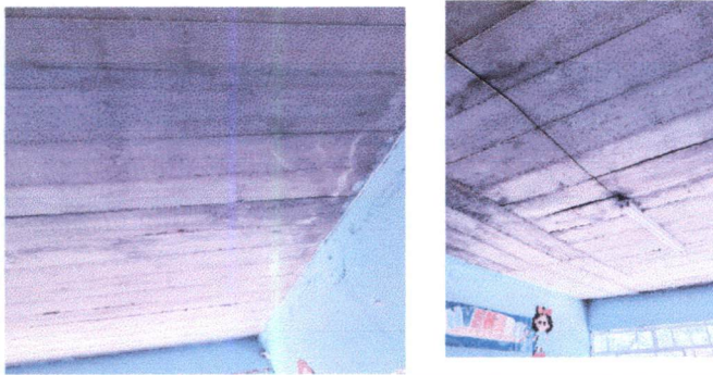
Foto 3: Aplicación de cernido en cielo de aula de 3ro. "A" y "B"
