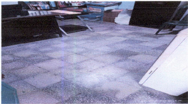
Foto 3: Sustitución de piso en área de Dirección
