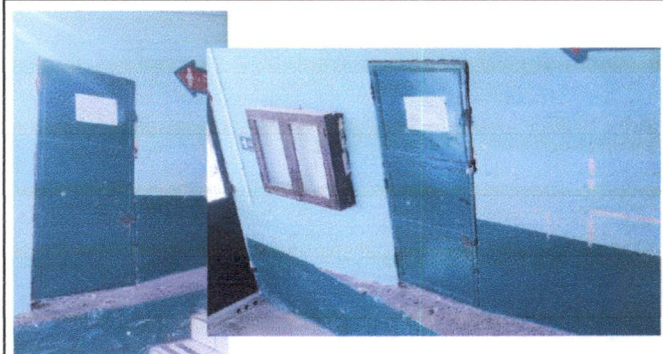
Foto 6: Sustitución de puerta en bodega de Educación Física.
