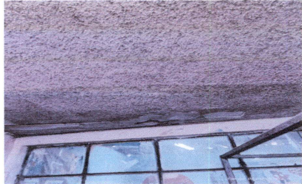
Foto 2: sellado de grietas y aplicación de cernido en loza de cocina
