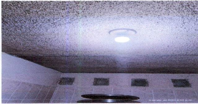
Foto 1: sustición de cernido en cielo de cocina
