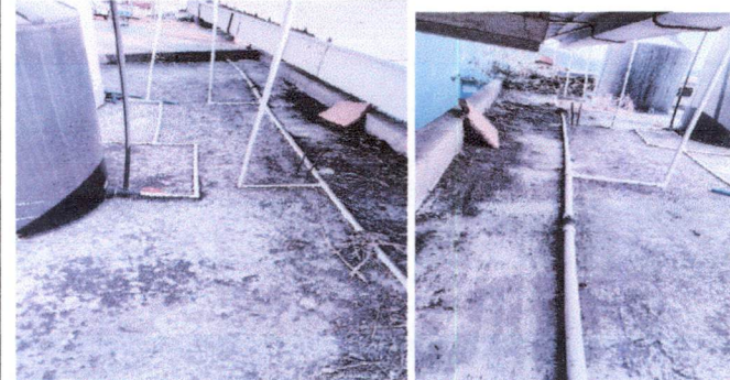
foto 4 : Impermeabilización de loza de servicios sanitarios de niños y niñas.
