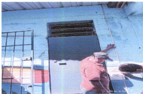
Foto 5: impermeabilización de loza y aplicación de cernido en exterior de aula de párvulos
