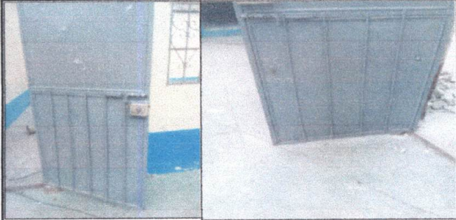
Foto7: MANO DE OBRA ESPECIALIZADA (HERRERIA) : Fabricación e instalación de puertas de metal en aulas de Párvulos y primero B. incluye pintura.
