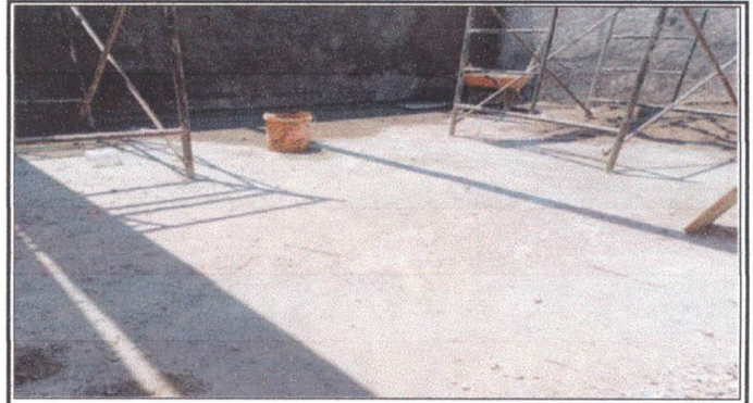
Foto 4: Sustitución de piso de torta de concreto por piso granito. Incluye levantado de torta de cemento existente, aplicación de mezlón y nivelación de suelo. En aulas de párvulos, primero B y 5to.
