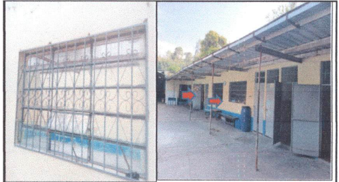
Foto 2: VENTANAS: Mantenimiento a balcones de metal, incluye: desmontaje, limpieza, pintura e instalación en párvulos y primero B.
