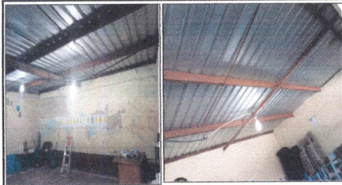
Foto 9: MANO DE OBRA ESPECIALIZADA (ELECTRICIDAD) : Instalación de unidades de iluminación en aulas de Párvulos, 1ro B y corredor.
