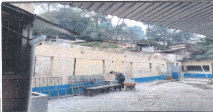
Foto 11: REPARACIÓN DE REPELLO Y CERNIDO DE PAREDES: Repello y alisado del area paredes exteriores, parvulos, primero B y paredes exteriores de baños. Incluye mantenimiento de paredes por mal estado,
