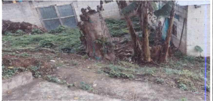
Foto 8: Mejoramiento de patio parte trasera, corte nivelación, suelo de cemento
