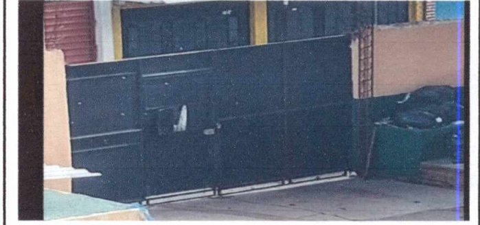
Foto 12: Mantenimiento de porton de ingreso, lijado cambio de tubo pasadores
