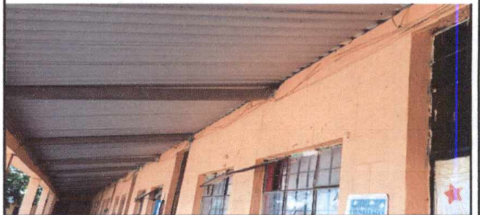
Foto 6: Sustitución de ducto eléctrico
