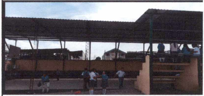
Foto 2: Sustitución de lámparas led tipo reflector, en cancha
