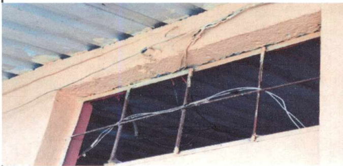
Foto 5: Reparación de sistema eléctrico
