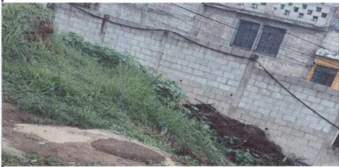
Foto 9: sustitución de línea principal y ducto electrico subteraneo
