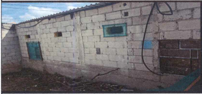
Foto 1: Demolición y tallado de vano en ventanas
