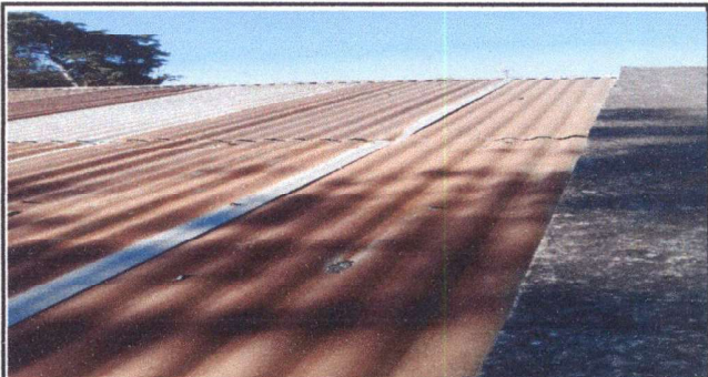
Foto 4: Sustitución de capote de lámina simple óxidado por capote de lámina calibre 26 para lámina troquelada en aula de 5to. Primaria Sección A
