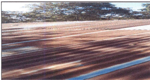
Foto 05: Sustitución de capote de lámina simple oxidado por capote de lámina calibre 26 para lámina troquelada en aula de 4to. Primaria Sección B
