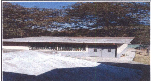
Foto 8: Mantenimiento de estructura de metal donde se colocará la nueva lámina de aluzinc troquelada calibre 26, lijada con fondo gris y aplicación de pintura roja en aula de 4to. Primaria Sección A
