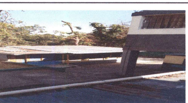
Foto 11: Sustitución de canal de PVC a canal rectangular de 20x15x240 de alto caudal aluzinc calibre 26 con pendientes en el canal en aula de 3ro. Primaria Sección A.
