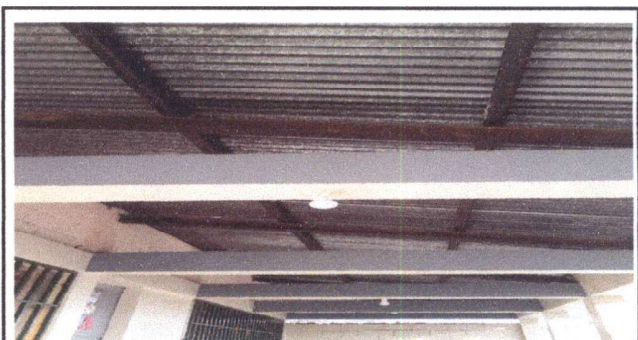
Foto 06: Mantenimiento de estructura de metal donde se colocará nueva lámina de aluzinc troquelada calibre 26, lijada, fondo gris y aplicación de pintura roja en aula de 5to. Primaria Sección A
