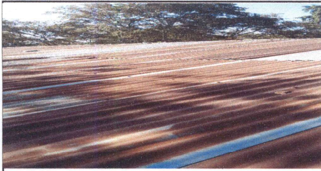
Foto1: Sustitución de lámina de zinc acanalada que se encuentran con mucho óxido por lámina de aluzinc troquelada calibre 26 en grados de 4to. Primaria Sección B y 5to. Primaria Sección A
