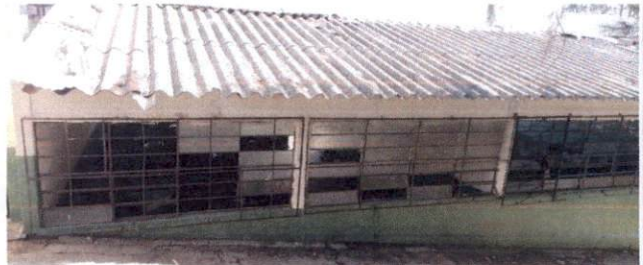
Foto 2: Cambio de lámina y mantenimiento de estructura
