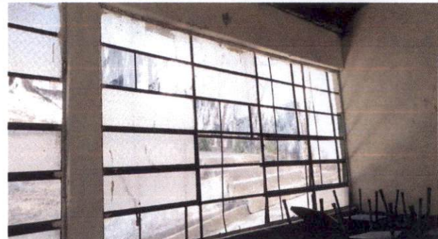
Foto 4: Cambio de vidrios
