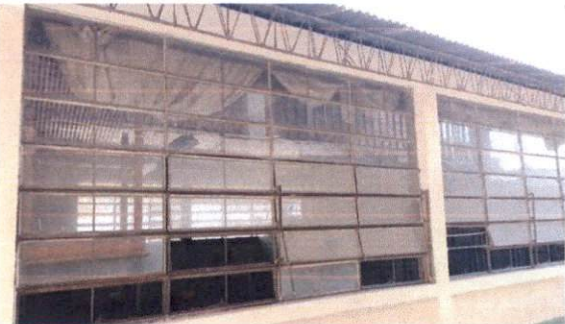
Foto 6: Cambio de vidrios
