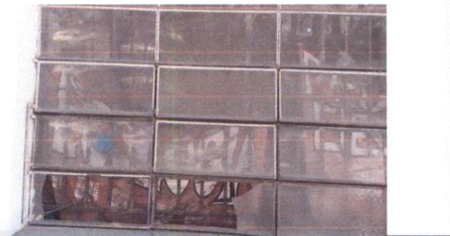
Foto 5: Cambio de vidrios
