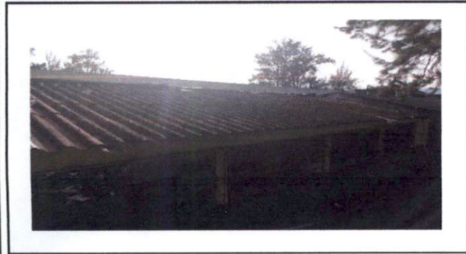
Foto: Cambio de techo
