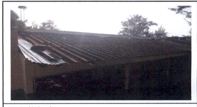
Foto: Cambio de techo
