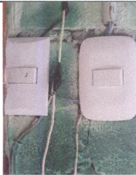
Foto 15: REPARACION DE SISTEMA ELECTRICO. Sustitución de timbre tipo Campana
