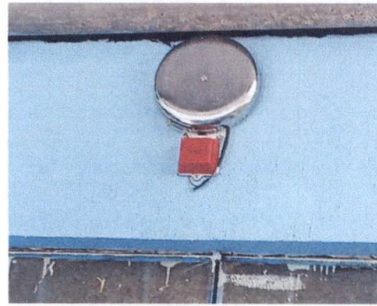
Foto 14: REPARACION DE SISTEMA ELECTRICO. Sustitución de timbre tipo Campana
