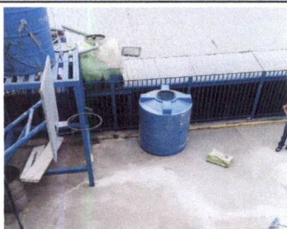
Foto 17: REPARACION Y MANTENIMIENTO DE CISTERNAS / DEPÓSITOS DE AGUA. Sustitución de deposito de agua 1,700 lts.
