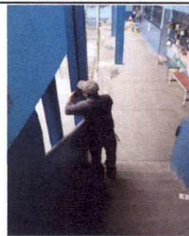
Foto 16: REPARACION DE SISTEMA ELECTRICO. Colocación de lampara nueva de 18W en area de gradas.
