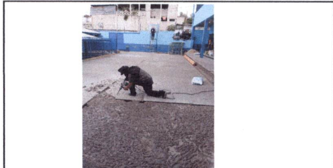
Foto 12: LOSA DE PATIO. Reparación de planchas de concreto en patio.
