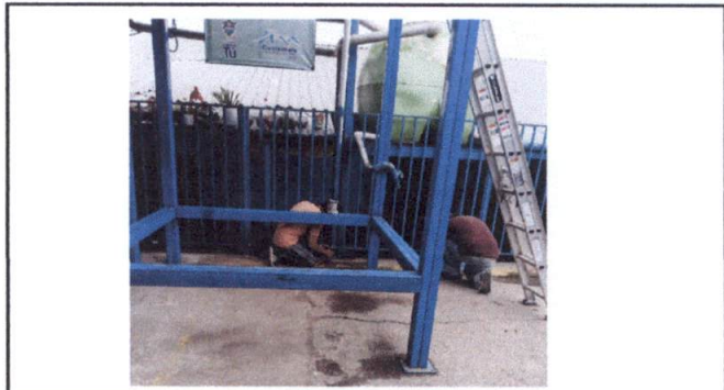
Foto 10: MANTENIMIENTO A BARANDAS mantenimiento a reja en área de cancha
