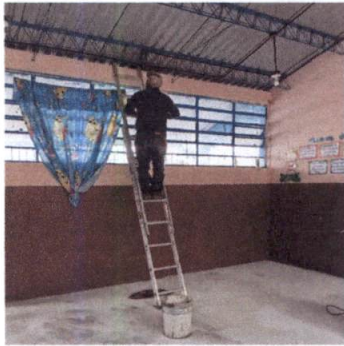
Foto 13: REPARACION DE SISTEMA ELECTRICO. Sustitución de focos led 40w.
