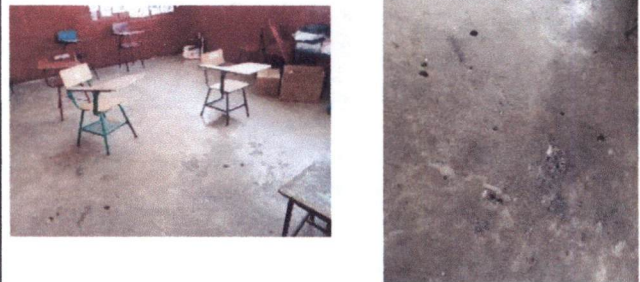
Foto 6: 6 PISO. Reparación de piso de concreto aula segundo nivel
