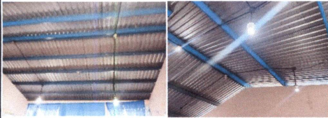
Foto13: 17 REPARACION DE SISTEMA ELECTRICO. Sustitución de focos led 40w.
