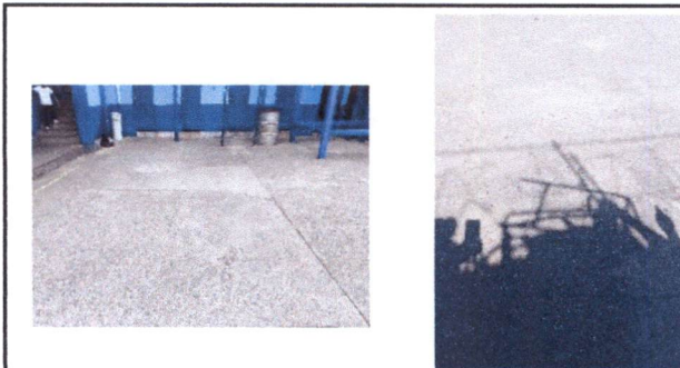
Foto 12: 16 LOSA DE PATIO. Reparación de planchas de concreto en patio.
