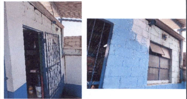
Foto 17: 17 REPARACION DE SISTEMA ELECTRICO. Colocación de lampara nueva de 18W en area de gradas.
