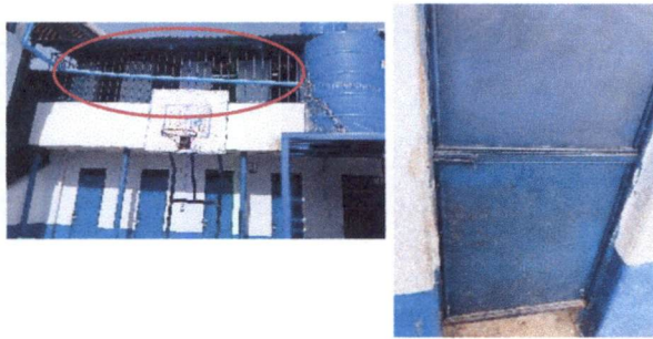
Foto 3: 4. PUERTA DE METAL. Mantenimiento de pintura en puertas de baño
