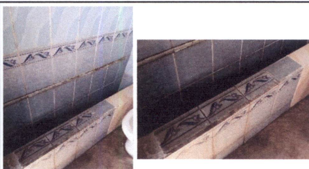
Foto 9: 10 SERVICIOS SANITARIOS Y SUS ACCESORIOS. Reparación de mingitorio
