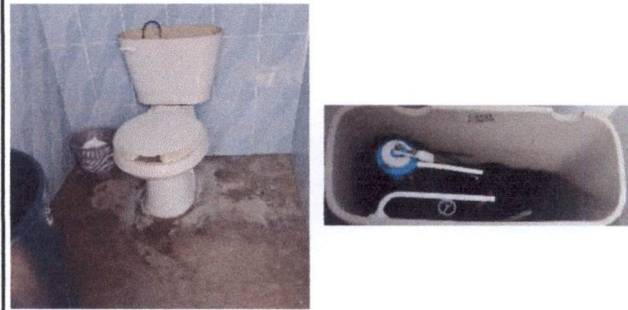
Foto 8: 10 SERVICIOS SANITARIOS Y SUS ACCESORIOS. Sustitución de tapadera tanque sanitario
