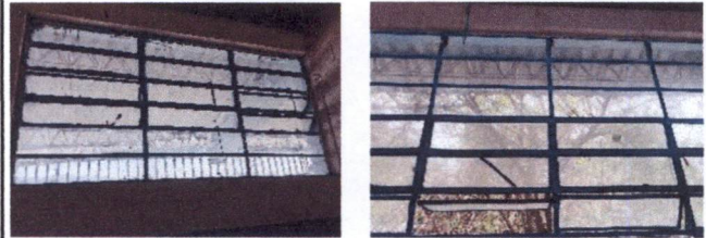
Foto 4: 5. VENTANA. Mantenimiento al pivote de ventanas
