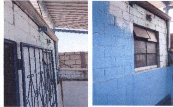
Foto 15: 17 REPARACION DE SISTEMA ELECTRICO. Sustitución de timbre tipo Campana
