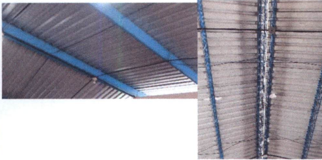
Foto1: 1. CUBIERTA DE LAMINA. Sustitución de capote
