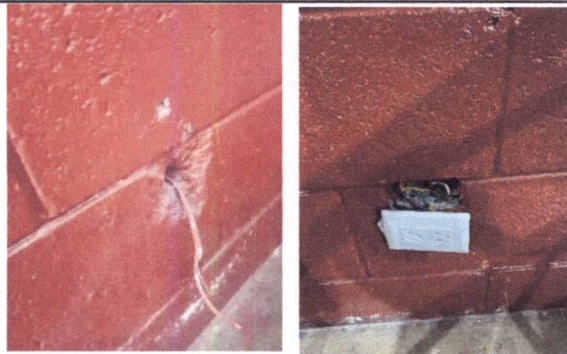
Foto 16: 17 REPARACION DE SISTEMA ELECTRICO. Sustitución de timbre tipo Campana
