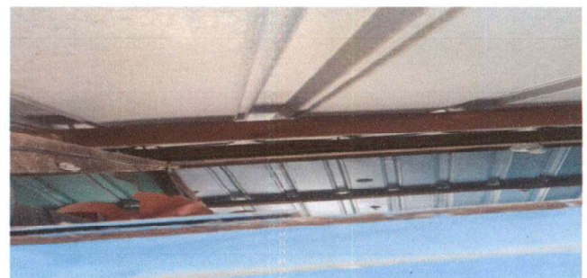
Foto 6: sustitución de capote
