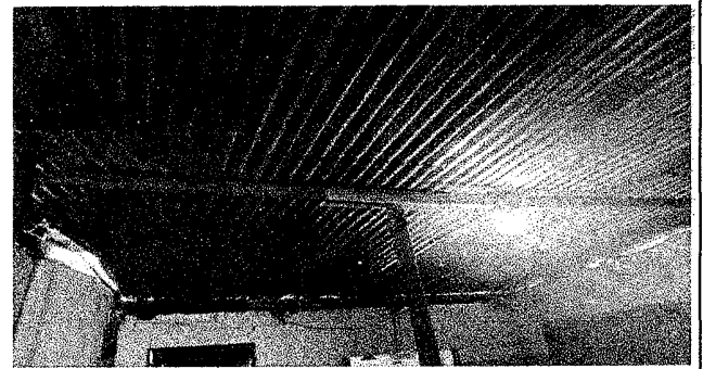
Foto 4: Cubierta de Lámina
