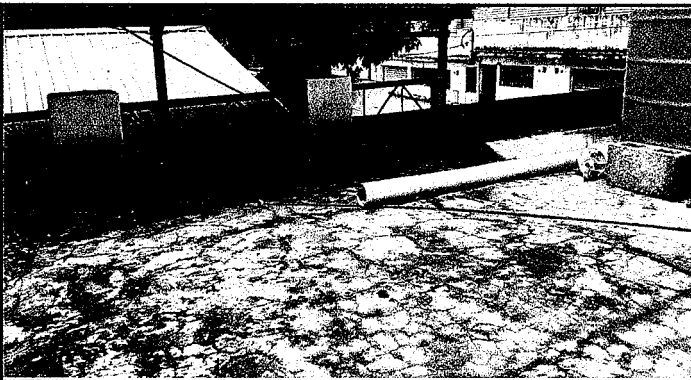
Foto 9. Mano de obra de 38m2 de mezclón en terraza y aplicación de dos manos de impermeabilizante.
