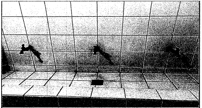
Foto 10 Sustitución de chorros y niples en sanitarios de niñas y niños.
