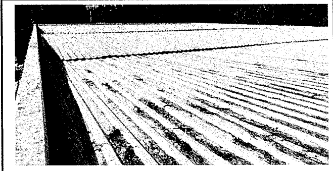
Foto 1: Vista de todo el techo
