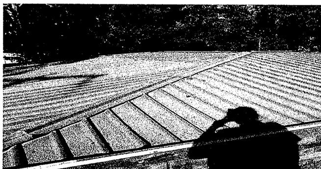
Foto 5: IMPERMEABILIZACIÓN DE LAMINA DE TECHO DE ESTRUCTURA
