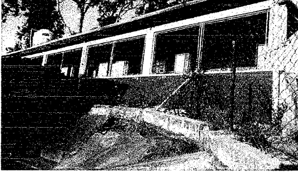
Foto1: Talud de graderío modulo D frente a cocina en mal estado
