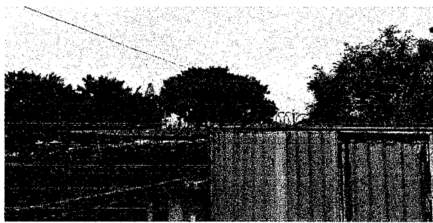
Foto 5: muro perimetral razor en mal estado
