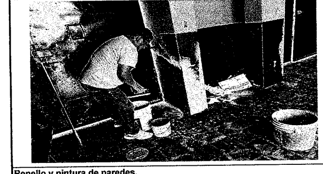
Repello y pintura de paredes.
