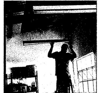
FOTO 4: SUSTITUCION DE DUCTO ELECTRICO MAS ACCESORIOS YA QUE EL CABLE SE ENCUENTRA CONECTADO A VARIAS AULAS A LA VEZ, CAUSANDO BAJONES EN LA PALANCA
