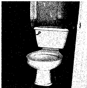
Foto1: Sustitución de 9 accesorios inodoro (contra llave, tubo de abasto y tanque), área de primaria
