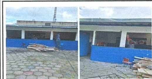
Foto: 3 FABRICACION E INSTALACION DE BALCON DE METAL
