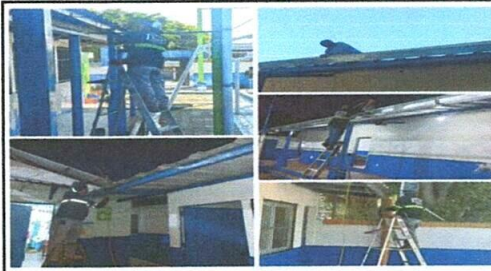
Foto: 4 INSTALACION DE CANALES EN REEMPLAZO DE BAÑOS Y LAVAMANOS PAREDES DE TABLA YESO
