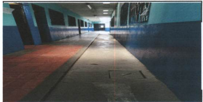
Foto 6.: Corrección de drenaje PVC
