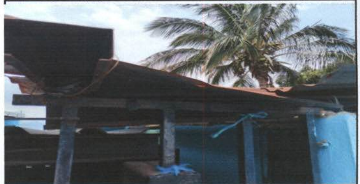
Foto 2.: Cambio de lámina troquelada dos bodegas
