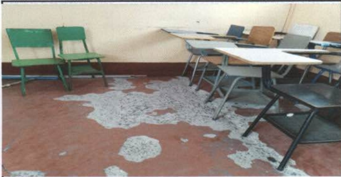
Foto 1.: Instalación de piso de 4 aulas de segundo nivel
