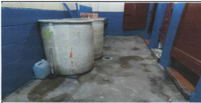
Foto 5.: Piso en corredor y baño
