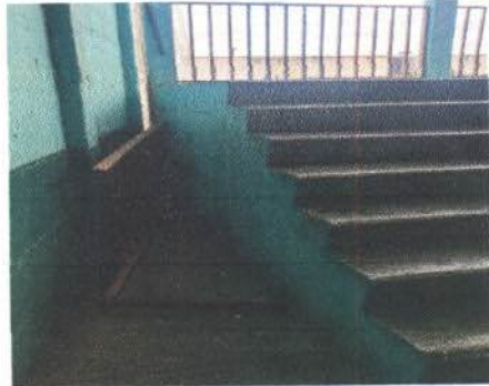
Foto 2: Colocacion de baranda nueva y mejorar el existente
