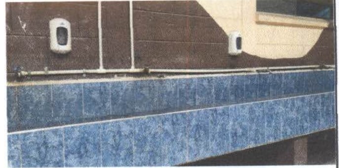
Foto 4: Mejorar el lavamano empotrando tubo HG con niples y estacion de 6 chorros
