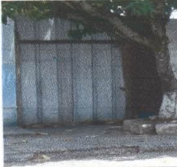
Foto 1: Retiro de lamina y colocacion de pared para mejorar la seguridad
