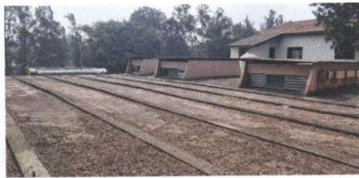
Vista sur en donde se instalará el laminado.
