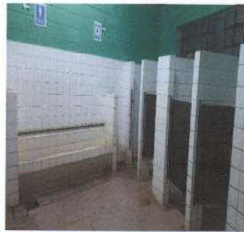
Foto 6.: Mantenimiento de puertas en sanitarios
