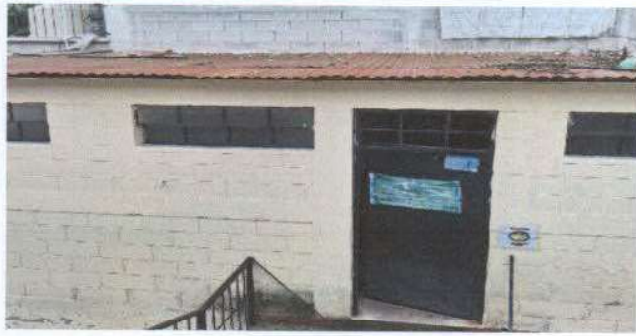
Foto 1.: Techado de sanitarios
