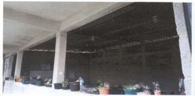
Foto 4.: Resanado en paredes
