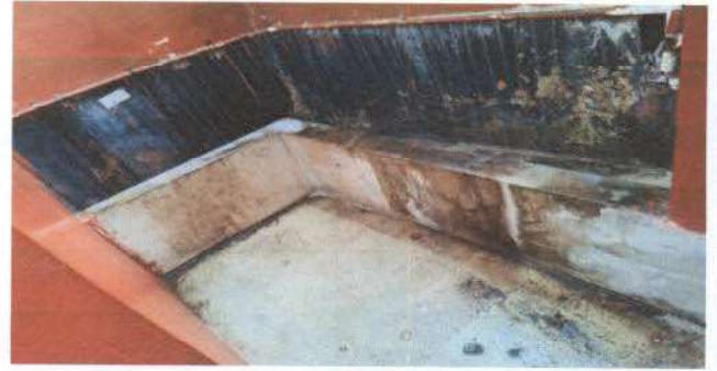
Foto 2.: Mejoramiento en sanitarios
