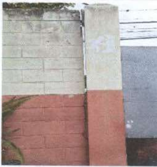
Foto 3.: Reparacionnde columna para porton
