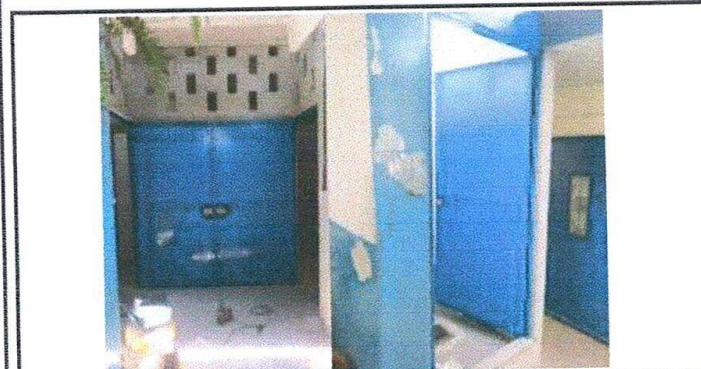
Foto 3: Puertas de baños y puerta área de lavandería.
