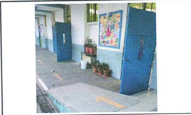
Foto 22: Puertas de aulas.
