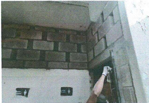
Foto 15: Repello área de baños.
