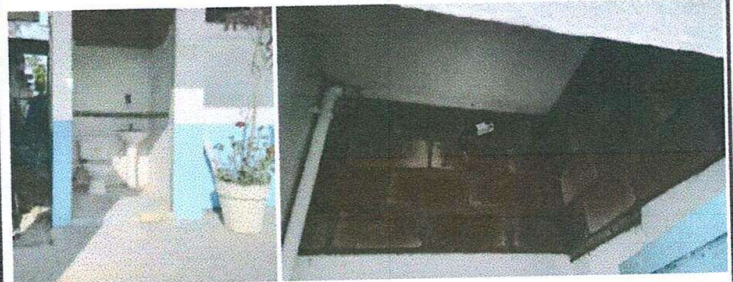
Foto 6: Baño de maestros, fotografía 2.
