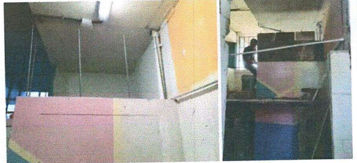
Foto 2: Baño de niñas y parte de atrás del baño de maestros.
