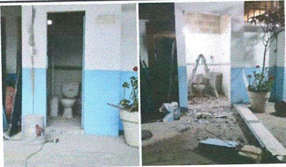
Foto 5: Baño de maestros, fotografía 1.
