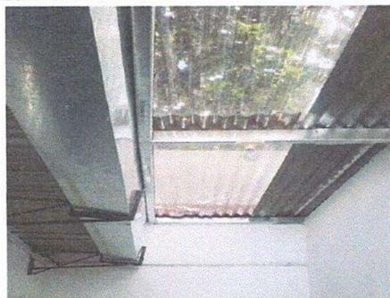
Foto 6: Corrección de pendiente en techo, cambio de láminas, ampliación de techo, levantado de pared y puerta metálica
