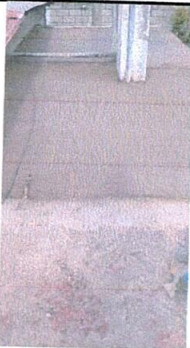
Foto 5: remozamiento pasillo módulo aulas
