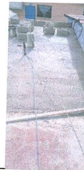
Foto 6: remozamiento módulo aulas
