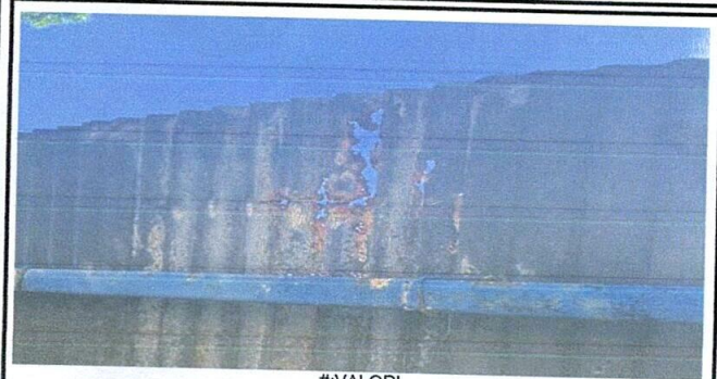
Foto: LÁMINAS DAÑADAS MÓDULO AUDIOVISUALES-DIRECCIÓN
