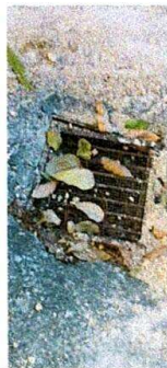
FOTO 5: RETIRADO Y REPARACIÓN DE REJILLAS
