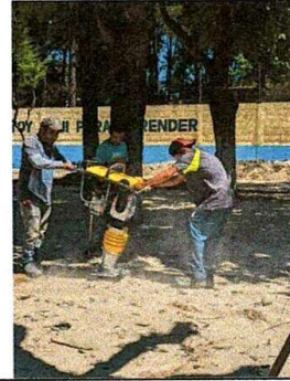
FOTO 4: APLANADO DE TERRENO
