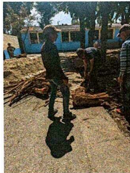
FOTO3: EXTRACCIÓN Y APLANADO DE RAICES
