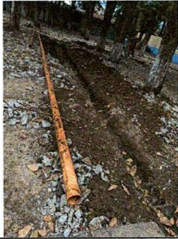
FOTO: LEVANTADO DE TORTA Y REPARACIÓN DE DRENAJES
