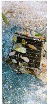
FOTO 5: RETIRADO Y REPARACIÓN DE REJILLAS
