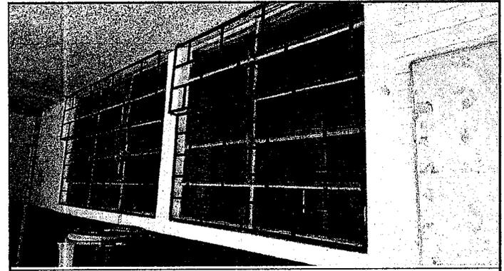
Foto 4: SUSTITUCION DE VENTANAS DE METAL POR VENTANAS DE PVC CORREDIZA Y MOSQUITERO DE 2.70mX1.40m
