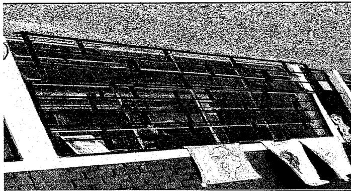
Foto 3: SUSTITUCION DE VENTANAS DE METAL POR VENTANAS DE PVC CORREDIZA Y MOSQUITERO DE 2.70mX1.40m
