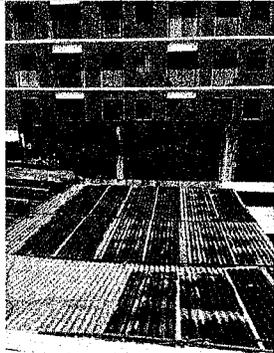
Foto1: SUSTITUCIÓN DE LÁMINA ACANALADA POR LÁMINA TROQUELADA
