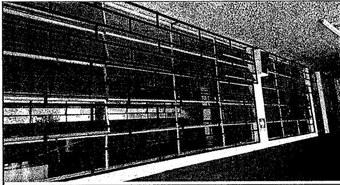
Foto1: SUSTITUCION DE VENTANAS DE METAL POR VENTANAS DE PVC CORREDIZA Y MOSQUITERO DE 3.85mX1.40m
