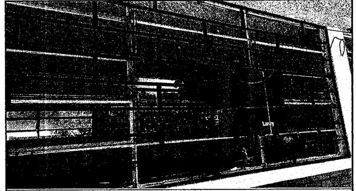
Foto 2: SUSTITUCION DE VENTANAS DE METAL POR VENTANAS DE PVC CORREDIZA Y MOSQUITERO DE 3.85mX1.40m
