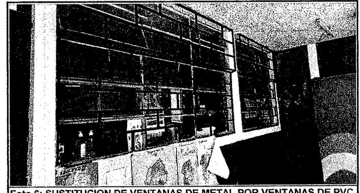
Foto 6: SUSTITUCION DE VENTANAS DE METAL POR VENTANAS DE PVC CORREDIZA Y MOSQUITERO DE 1.80mX2.40m
