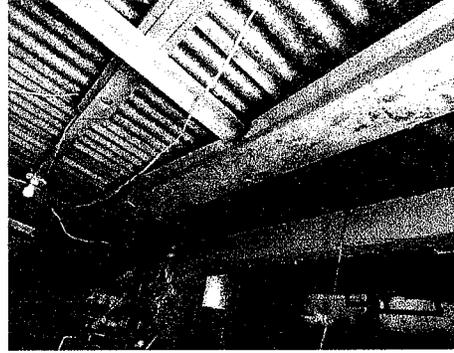
Foto2: SUSTITUCIÓN DE CANALES Y BAJADA DE AGUA PLUVIAL
