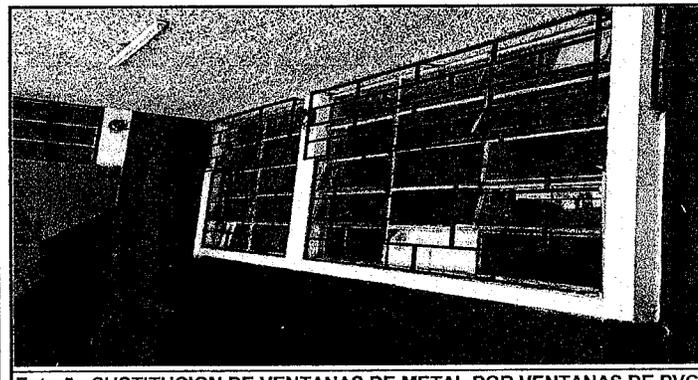
Foto 5: SUSTITUCION DE VENTANAS DE METAL POR VENTANAS DE PVC CORREDIZA Y MOSQUITERO DE 1.80mX2.40m
